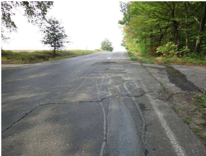
Obr.4.E Poruchy vozovky – směr od Býchor
