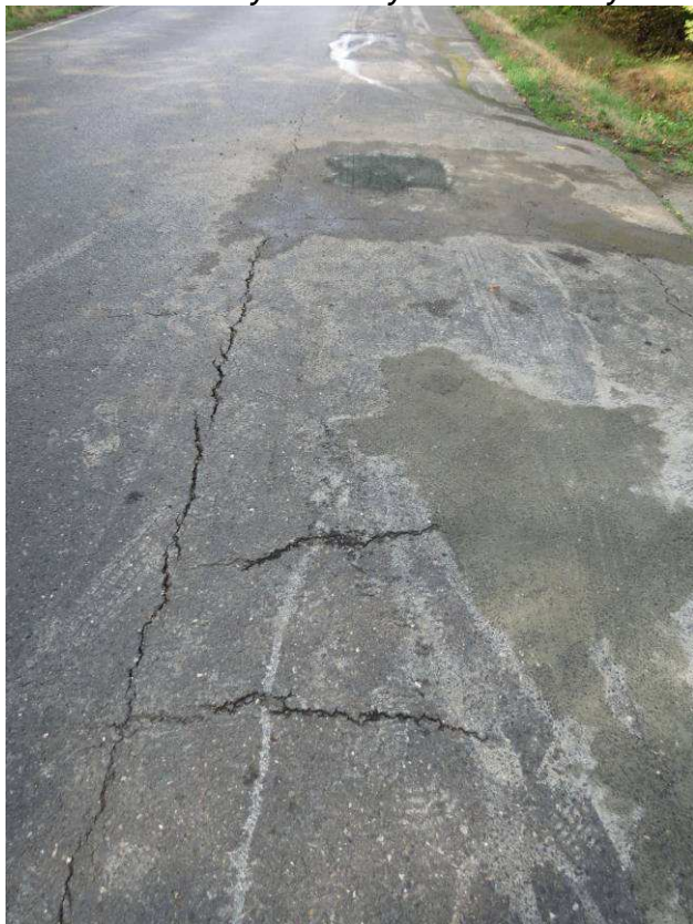
Obr.5.E Poruchy vozovky – směr od Býchor – detail
